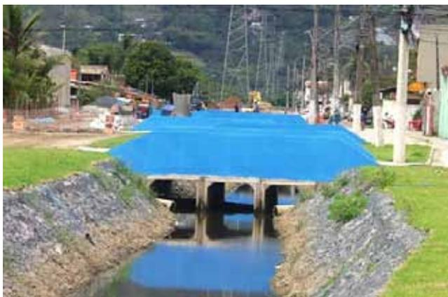
No canal da Alta Tensão, são pelo menos 554 aduelas que foram instaladas no local e que vão interligar com as já instaladas no Córrego Itororó. Atualmente está sendo executado o gabião (tipo colchão Reno), aumentando a vazão e facilitando o fluxo de águas
