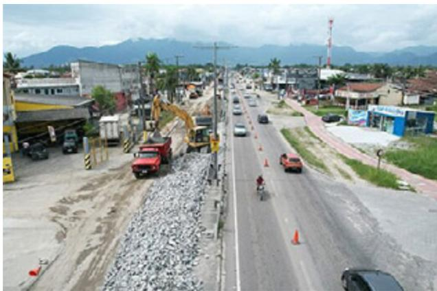
Os trabalhos de fresagem e a colocação de pedras são feitas em vários trechos e tem o objetivo de substituição do antigo pavimento por um novo. Vários trechos apresentam problemas de deterioração, o que interfere na segurança dos veículos e riscos de acidentes.
