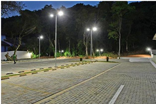
características notáveis do espaço é o piso pavimentado com lajotas de concreto intertravado, que, além de resistente, permite uma drenagem eficiente do solo, prevenindo alagamentos e garantindo a segurança dos veículos estacionados.
